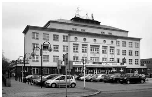
Náměstí SNP v Ostravě-Zábřehu, současný stav
