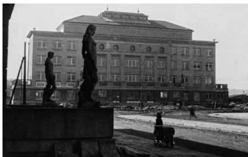
Náměstí SNP v Ostravě-Zábřehu při výstavbě
