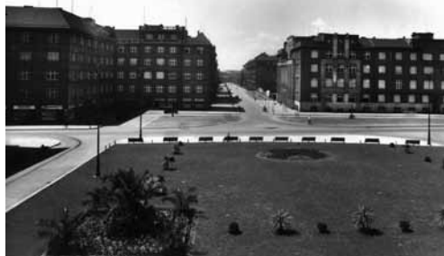
Prokešovo náměstí se zatravněnou plochou, na protější straně úprava již s dlážděním
